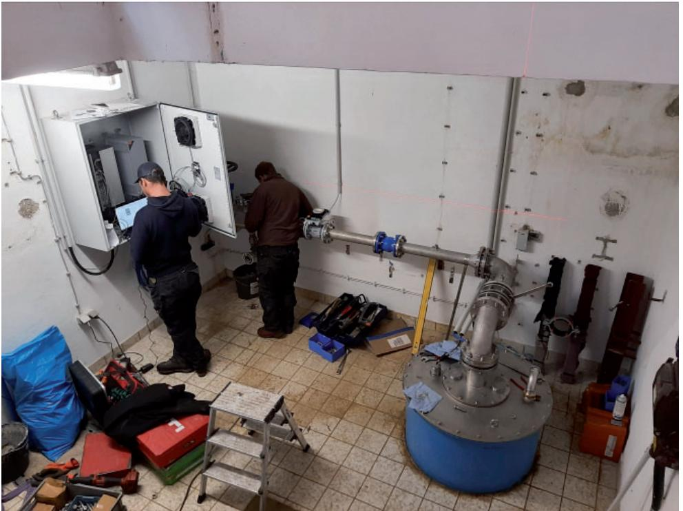
Umbau Ende November starten. Zunächst wurde der Brunnen vom Netz getrennt, gleichzeitig wieder unser Notverbund mit Schongau geöffnet. Dann erfolgte der Rückbau der kompletten Wasserleitungstechnik im Brunnengebäude. Auch der größte Teil der Elektrotechnik wurde rückgebaut.
